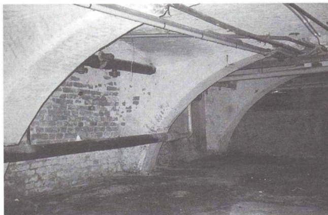
Afb. 3 De rechterkelder van Hinthamerstraat 100, naar voren gezien. Links de dertiende-eeuwse zijmuur van Hinthamerstraat 102-104, gemetseld met grote bakstenen in 'vlaams verband' (Foto: BAD).
